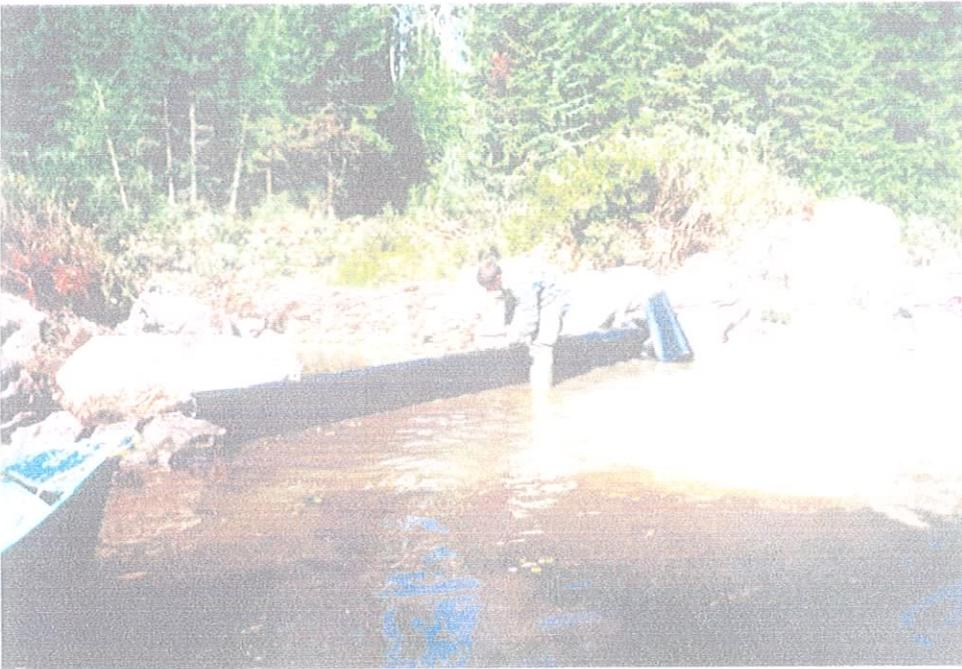
Mise en place de la geomembrane qui recouvre le grillage
